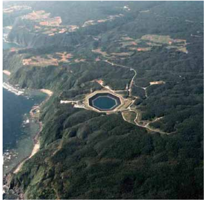
沖縄海水揚水発電所
