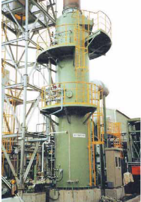
脱硫装置外観
