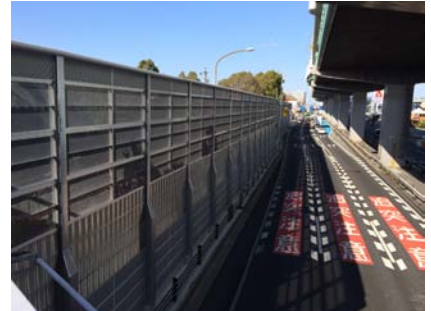
NNCパネル施工例
