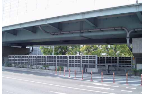
ACFユニット施工例
