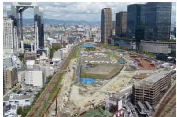
工事が進むうめきた2期
