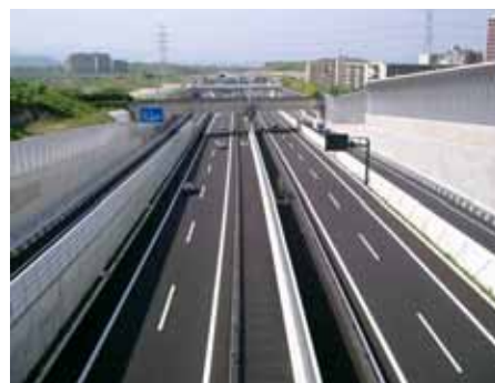
第二京阪道路（松井山手付近）
