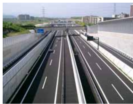
第二京阪道路（松井山手付近）
