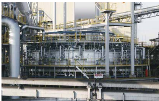
炼铁粉尘循环利用设备
