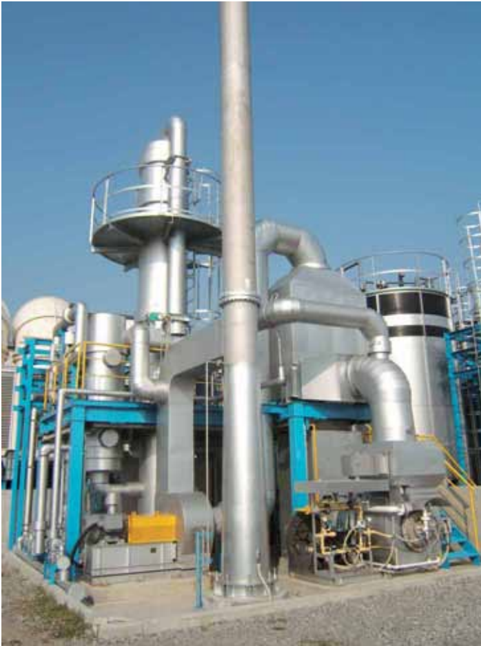
アンモニアガス分解システム
