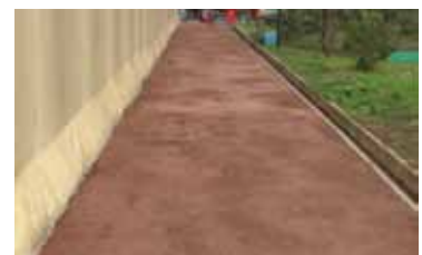
ジオレソイル施工後
