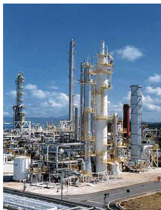
排ガスから回収したCO 2 による尿素増産適用例(マレーシア)
