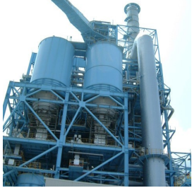
SNCR脱硝装置尿素溶解システム 外観
