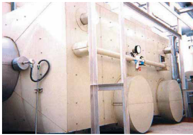
SCR脱硝装置反応器 外観
