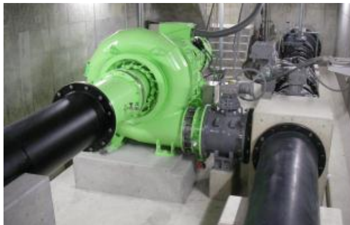
小水力発電設備(水力発電機)桜井浄水場
