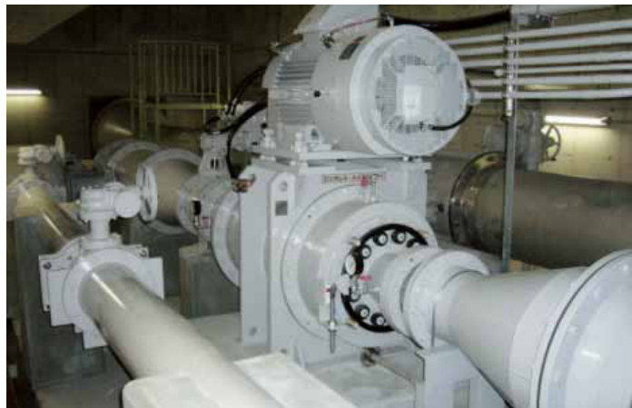
小水力発電設備(水力発電機)広域水道センター
