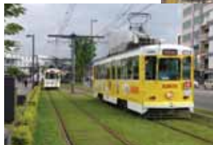
軌道敷緑化例(熊本市交通局)
