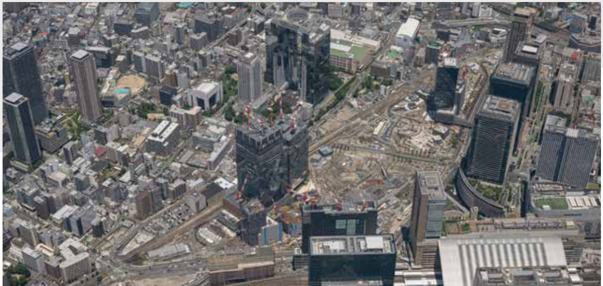
工事状況(2023年6月時点) 提供：グラングリーン大阪開発事業者
