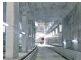
地下に建設中のトンネル
