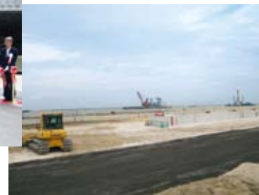
PC18ターミナル工事現場 (2009年7月)
