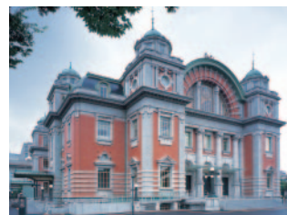
上：大阪国際会議場 下：大阪市中央公会堂
