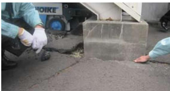
鴻池運輸仙台食品流通センターでは建物が沈下し、路面亀裂・段差が生じた
