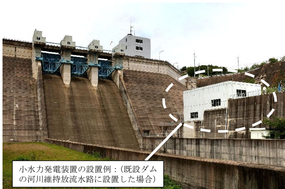
(図 小水力発電装置の設置例)
